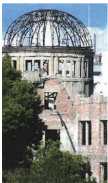
保存整備された原爆ドームの鉄骨部分
